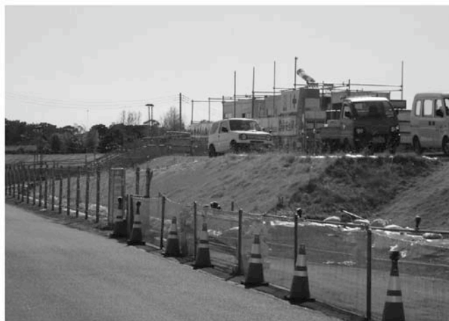
茅ヶ崎西部に住む人々から完成を望まれている相模川左岸築堤護岸工事
